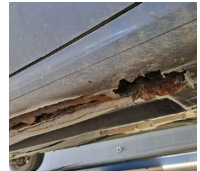
STRUKTURALNA KOROZIJA NOSIVIH DJELOVA (PRAGOVA)
